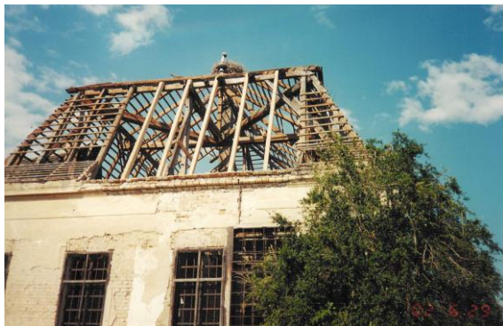
a déli épületszárnyon a tetőszerkezetet részben cserélték, a szaruzat alatti szerkezetek (kötőgerenda és mellszorító hálózat, székszerkezet) megmaradtak, a korábban részben leszakadt fafödémét kibontották
