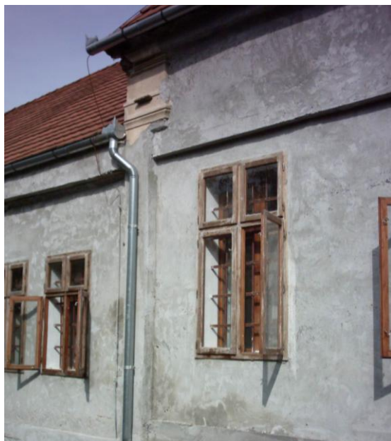
a homlokzaton az ép vakolat-tagozatokat meghagyták, hogy a homlokzatfelújítás mintájául szolgálhassanak, új ablakok kerültek a külső, és belső síkra, a régi rács meghagyásával. a déli épületszárny ablakainak osztása nem egyezik az eredeti hatszemes osztással
