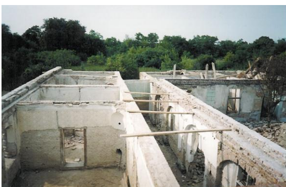
a régi szárny teljes fafödémét és fedélszerkezetét lebontották
