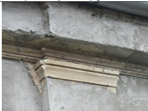
pilaszter fej - nyugati homlokzat
