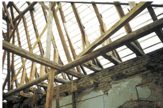
a déli épületszárnyon a tetőszerkezetet részben cserélték, a szaruzat alatti szerkezetek (kötőgerenda és mellszorító hálózat, székszerkezet) megmaradtak, a korábban részben leszakadt fafödémét kibontották
