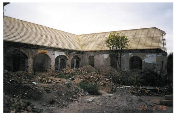
a vakolat leverése feltárultak a tornácívek a belső déli homlokzaton ...
