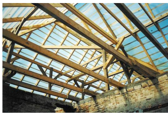
a teljes épületben vb koszorú és új fafödém, a régi szárnyban új fedélszék is készült
