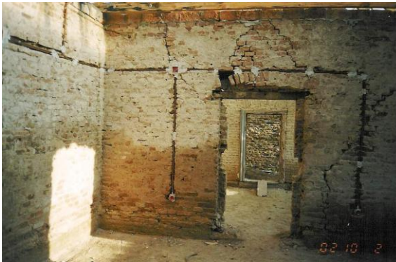
a teljes belső térben eltávolították a vakolatot kiépítették a gépészetet
