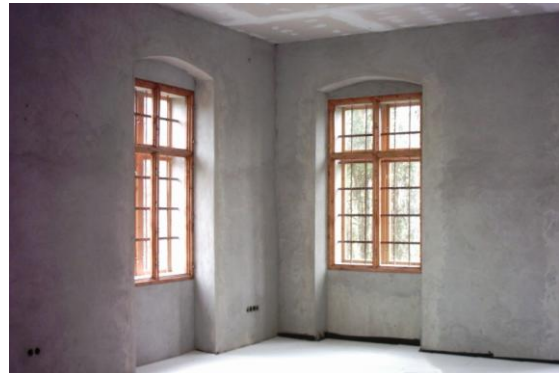
a teljes épületben gipszkarton álmennyezet, új vakolat és aljzatbeton készült
