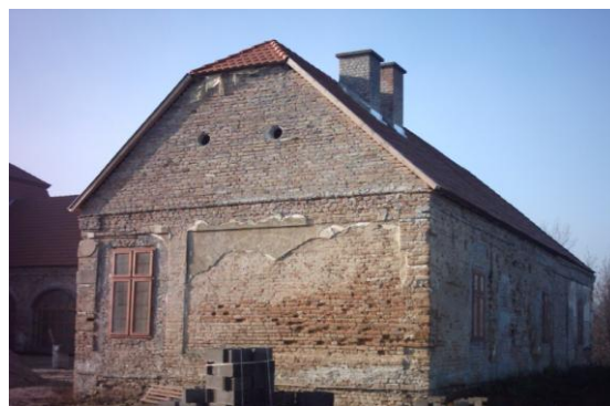
a vakolat leverése feltárultak a tornácívek a belső déli homlokzaton ...
