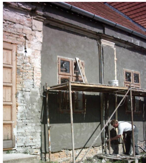
a homlokzaton az ép vakolat-tagozatokat meghagyták, hogy a homlokzatfelújítás mintájául szolgálhassanak, új ablakok kerültek a külső, és belső síkra, a régi rács meghagyásával. a déli épületszárny ablakainak osztása nem egyezik az eredeti hatszemes osztással
